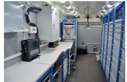
Фото 2. УМК СВР-1. Размещение рабочих мест и оборудования
